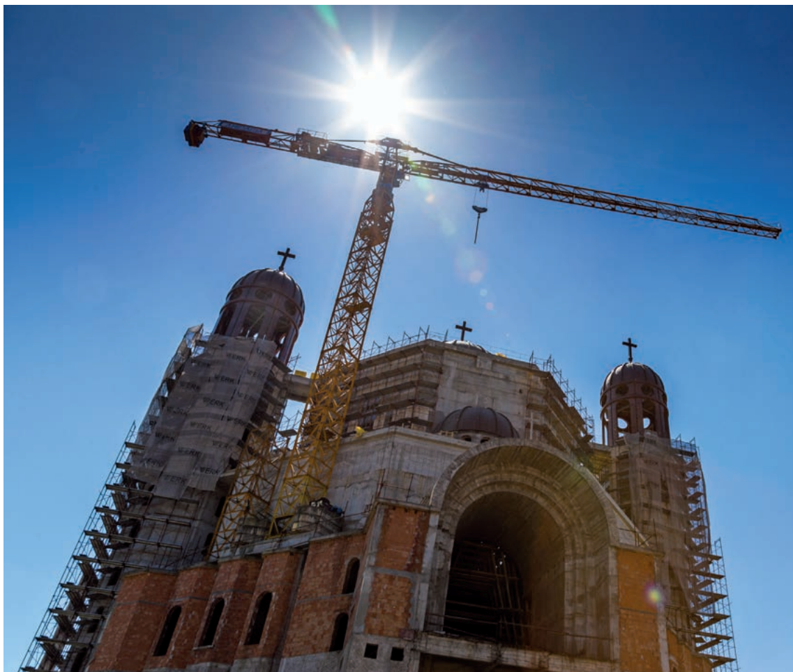
Kirchenbau in Rumänien mit deutscher Steuerbegünstigung
